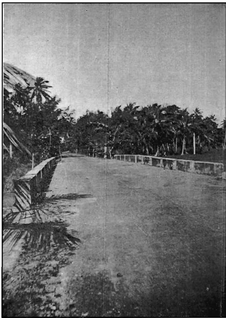
VISTA DEL PUENTE-GUAYABO, AGUADA, P. R.
